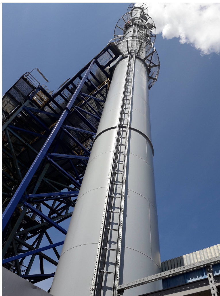
Zdjęcia 2 – emitor E-1 (podest obsługowy, trasa kablowa).
